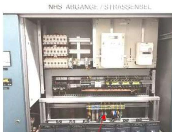
Alte NS-Verteilung (kein Berührungsschutz, Kabelführung z. T. hinter blanken Sammelschienen)
