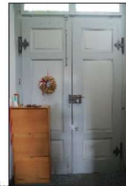
Beidseitig bauzeitliche Abschlüsse mit originalen Beschlägen und Kastenschlössern
