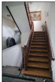
Vertikalschliessung mit bauzeitlicher Wangentreppe mit Staketengeländer, Trittstufen und Belag am Wendepodest materialisgerecht erneuert (Eichenholz)
