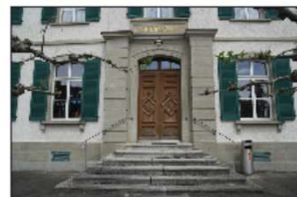
Bauoriginaler Zugang im Mittelrisalit der Südseite; dreiläufige Freitreppe mit Kunststeinstufen und modernem Geländer (struktureller Schutz)
