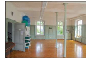
Bauzeitliche gebäudebreite Halle mit Fischgrätparkett (Bucheinholz) und dreizoniger Stuckdecke; Farbgebung des 3/4-Täfers evtl. nach Befund erneuert
