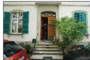
Schlichter gestalteter Zugang der Nordseite; erneuerte, einläufige Freitreppe mit Kunststeinstufen und modernem Geländer (struktureller Schutz)
