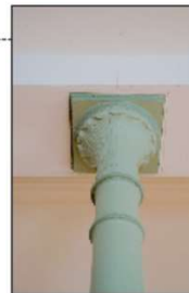
Bauzeitliche gusseiserne Säulen, Unterzüge gipsplattenverkleidet
