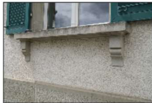
Erneuerter Wormservergips (verm. 1930er Jahre) in gutem Zustand; originale Sandstein-Fensterbänke und Konsolen nachträglich durch Kunststeinelemente ersetzt
