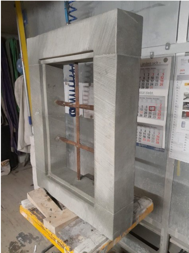
Aus bestehenden Sandsteinquadern neu erstelltes Fenster
