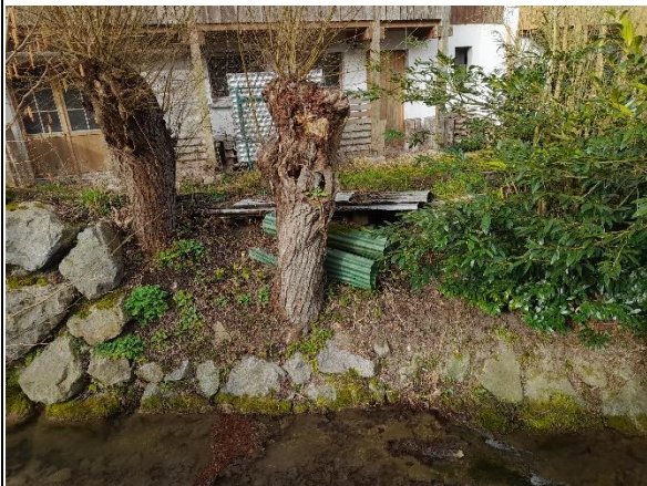
Abbildung 1: Foto Ortsbegehung Rütelibach km 250 - 350 (1)
