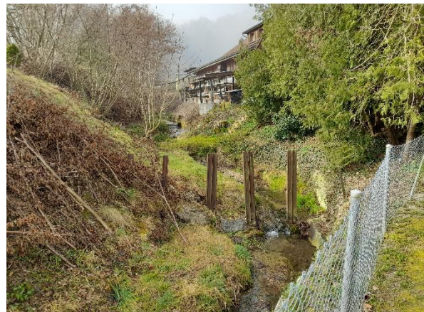
Abbildung 2: Foto Ortsbegehung Rütelibach km 250 – 350 (2)
