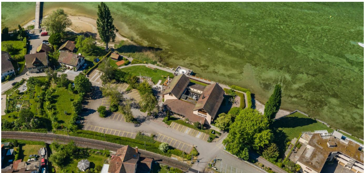
Drohnenfoto der aktuellen Situation
