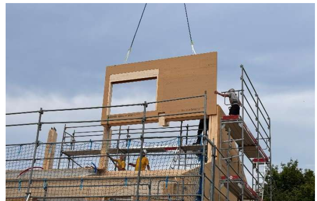
Mit dem Elementaufbau nahm das neue Gebäude sichtbar Form an.
